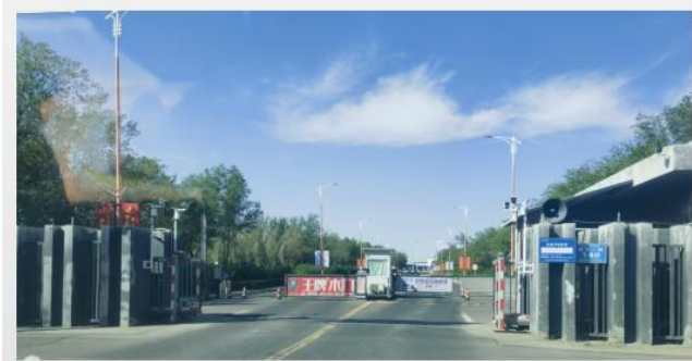
现状道闸为双向双闸，但实际为单闸道进出口，建议远期拓建至三出三进，共6个道闸。
